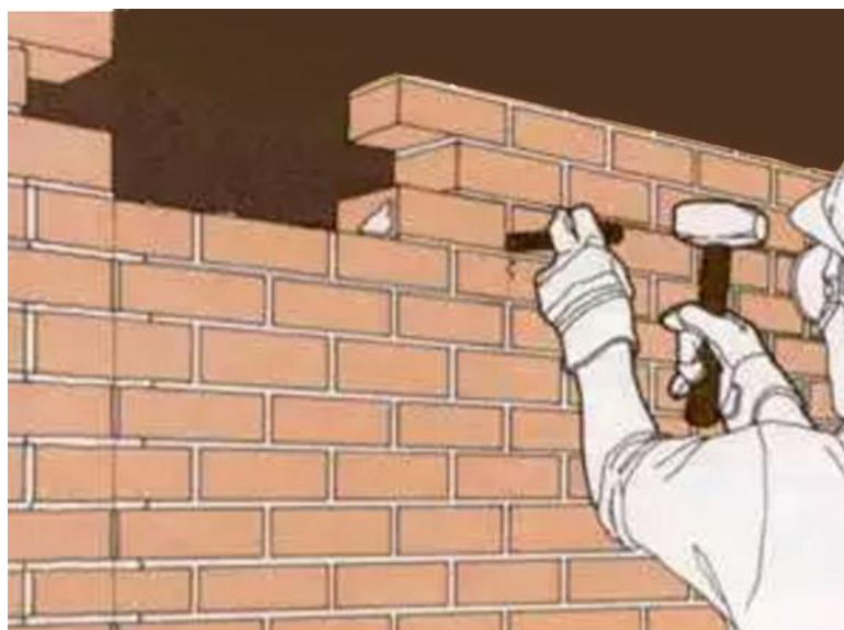
Демонтаж стен из кирпича
